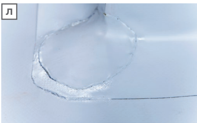
Л. Для надежности герметизации угловой точки «внешнего угла» на поверхности кровли устанавливают накладку внешнего угла.
