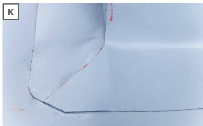
К. Полностью изолированный внешний угол плоской кровли.
