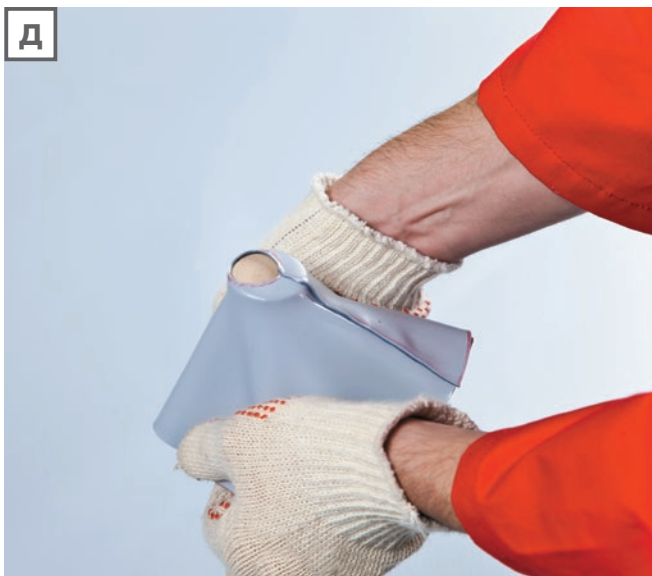
Д. И пока не остыла мембрана натягиваются на изолируемый проход.
