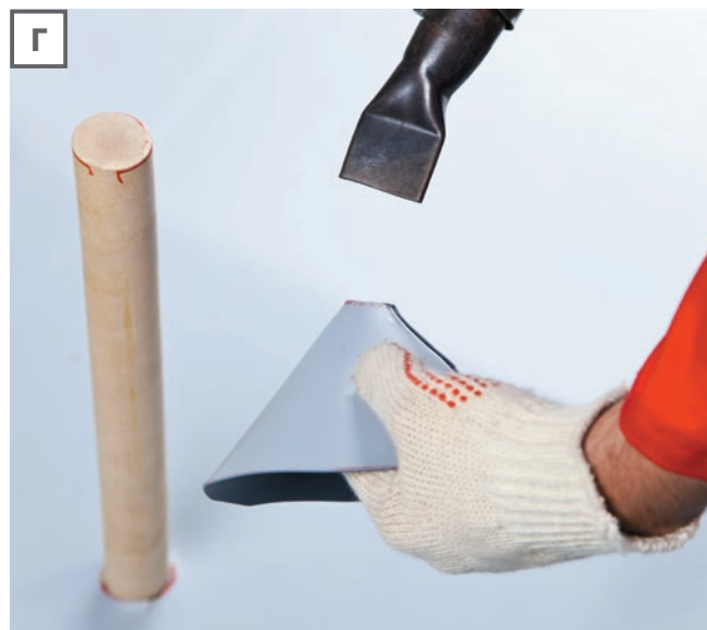
Г. Разогреваются внутренняя и внешняя кромки конуса.
