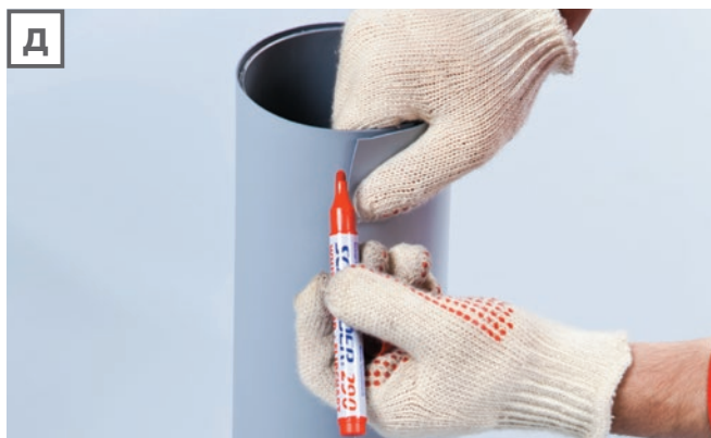
Д. Эта полоска мембраны примеряется на трубе, отмечается рисками положение свернутой на трубе мембраны.
