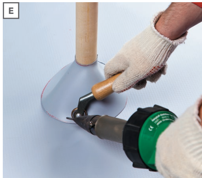
Е. После этого конус мембраны по всей поверхности приваривается к кровельной мембране
