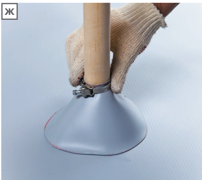
Ж. Вершина конуса обжимается металлическим хомутом.
